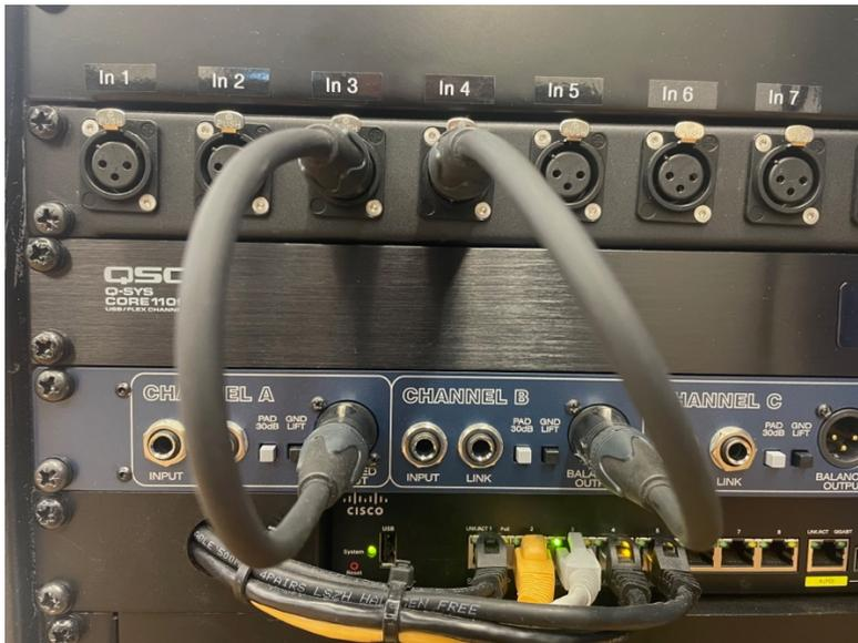
Auf diesem Foto werden zwei Kanäle der integrierten DI-Box auf die Inputs 3 und 4 gegeben (vier kurze XLR Patch-Kabel sind in der Schublade). Am Input der DI-Box kann dann direkt ein Instrument via Jack-Kabel (E-Gitarren-Stecker) angeschlossen werden, bspw. Keyboard, E-Bass, Piezo-Kontaktmikrofon etc.
